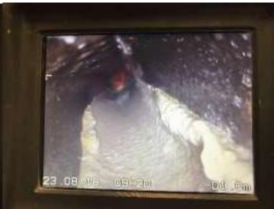
Verbindungsrohr zwischen Macerator und Wand
