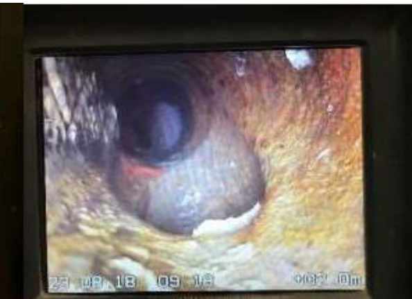
1 Meter weiter - Zulauf Kanalrohr von Toilette
