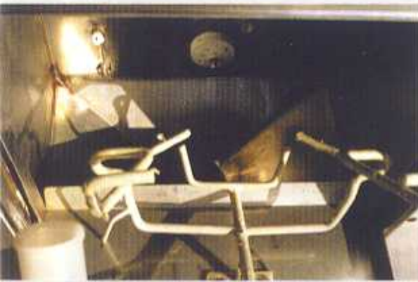
Problemzone: Keime wachsen vom Spülkammersystem über die Spülkammerwand und die Zuleitungen in den Wassertank zurück.
